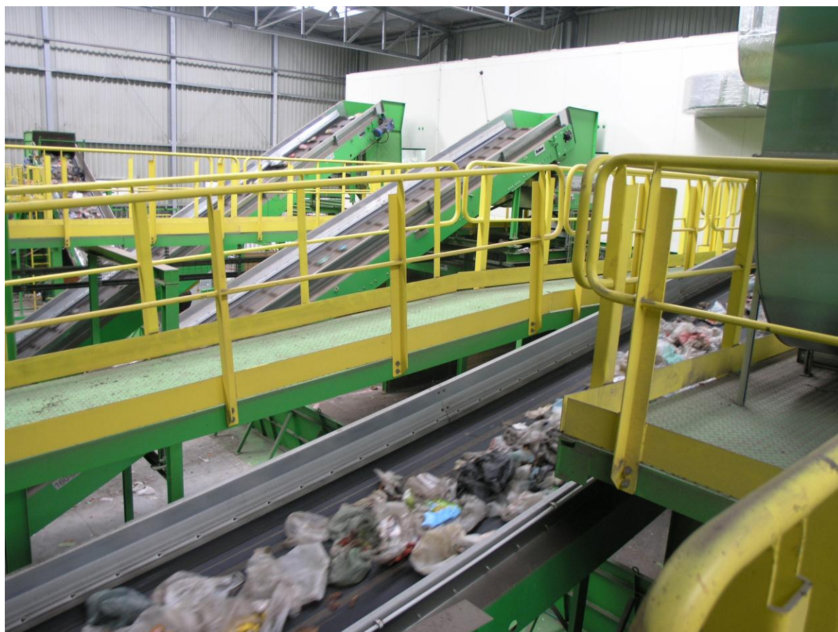
Fot. 6.5. Regionalny Zakład Gospodarki Odpadami w Woli Pawłowskiej – sortownia.
